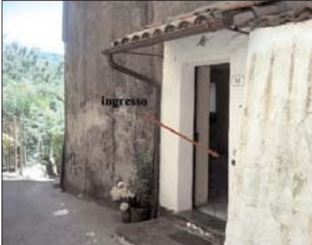
Ingresso al deposito ubicato al piano terra
