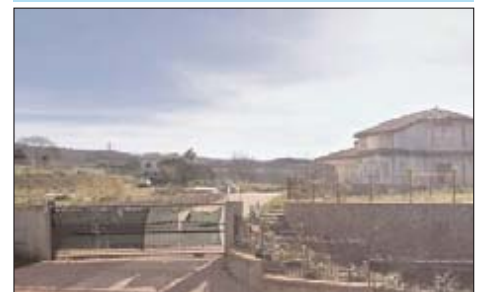
Foto 2- Facciata lato sud
